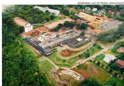
Técnica a ser utilizada irá recuperar traços do empreendimento
