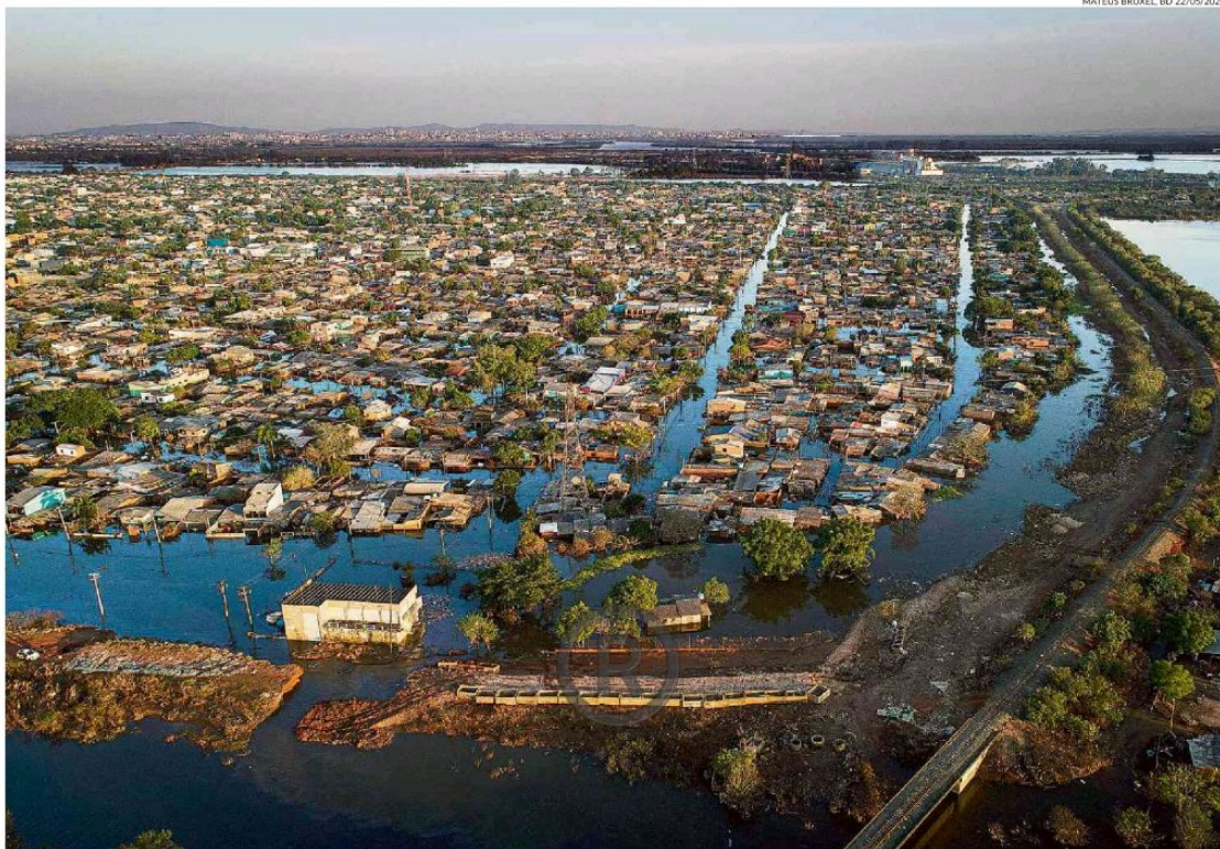
Danos em dique de proteção pioraram situação do bairro Mathias Velho, no município de Canoas, a exemplo de outras cidades vizinhas, incluindo a zona norte de Porto Alegre
