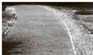
Faixa de concreto de três metros de largura
