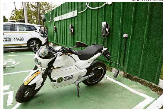
Estrutura também conta com uma estação de carregamento
