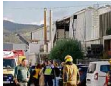
Equipes de resgate trabalham no local que teve parte destruída
