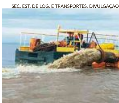
Máquinas já em funcionamento
