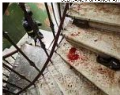
Socorrista percorre edifício danificado por ataque em Odessa
