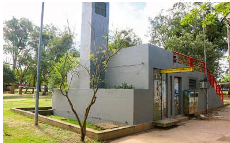
Estrutura foi a mais abalada pela enchente e está reconstruída
